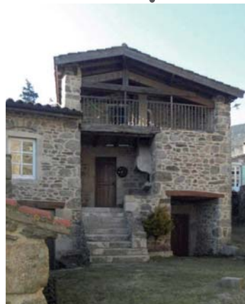
Exemple de débord de toiture
