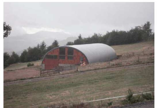
Exemple de tunnel agricole intégré de teinte grise et bardage bois
