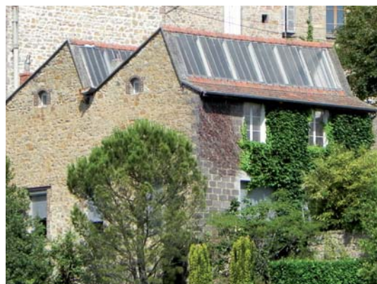
Exemple de toiture en Shed
