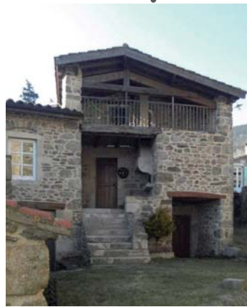
Exemple de débord de toiture
