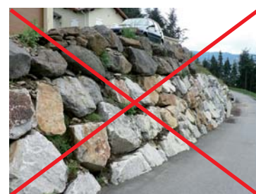
Exemple d'enrochements de type cyclopéen
