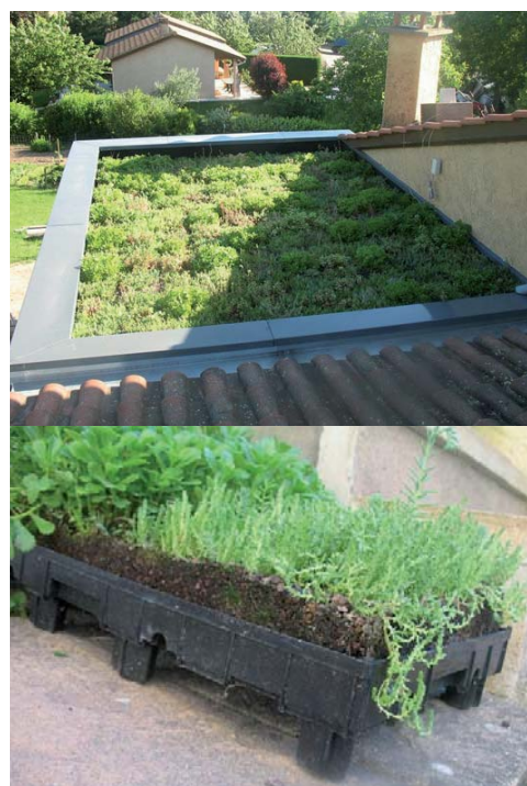
Exemple de toiture-terrasse végétalisée et bacs pré-cultivés
