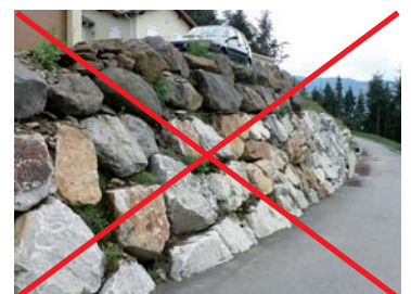
Exemple d'enrochements de type cyclopéen
