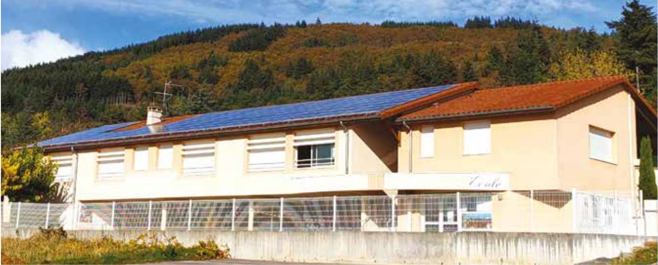
Une installation de 36 Kwc permettant la production annuelle correspondant à la consommation de 19 foyers (hors chauffage).
